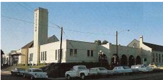
Het stationsgebouw vanaf de straatzijde gezien
