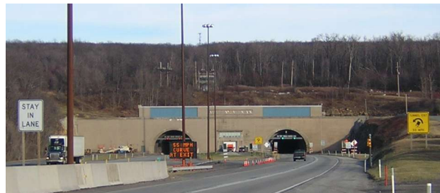
De westelijke ingang van de 1850 m lange Allegheny Mountain tunnel
