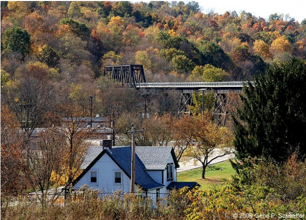
Het nog bestaande McDonaldviaduct (19-10-2008)
