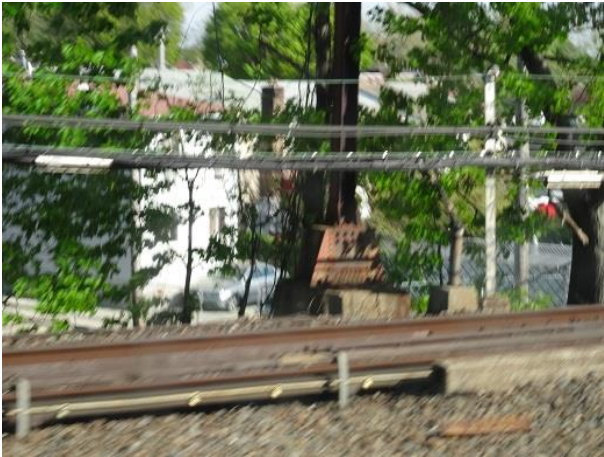
Bijzonder is dat op sommige delen langs het spoor de bovenleidingportalen gedeeltelijk er nog staan!
