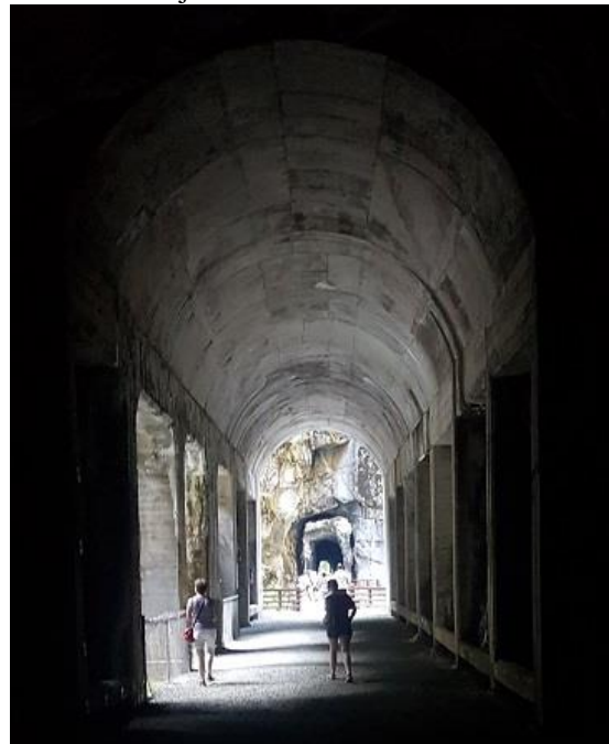
De tunnel met de "window".
