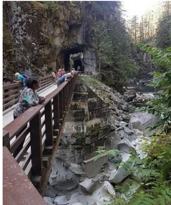
Eén van de twee bruggen over de Coquihalla rivier.
