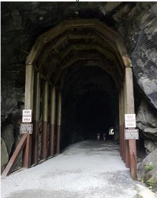
Van dichtbij blijkt hoe hoog de spoortunnels inwendig zijn.
